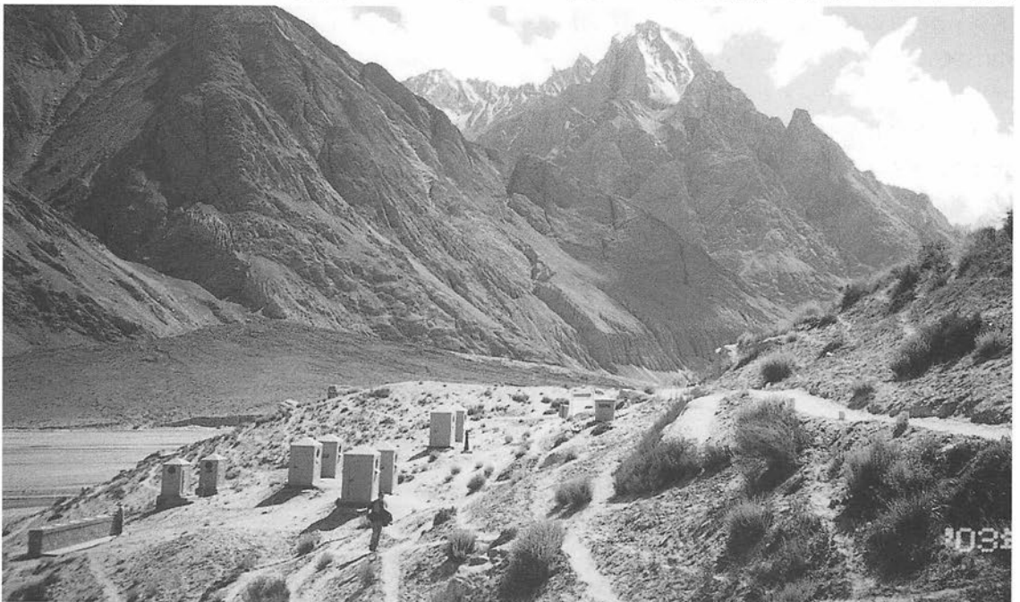
▲パユーキャンプ場のトイレ棟群と左端が洗面場。
